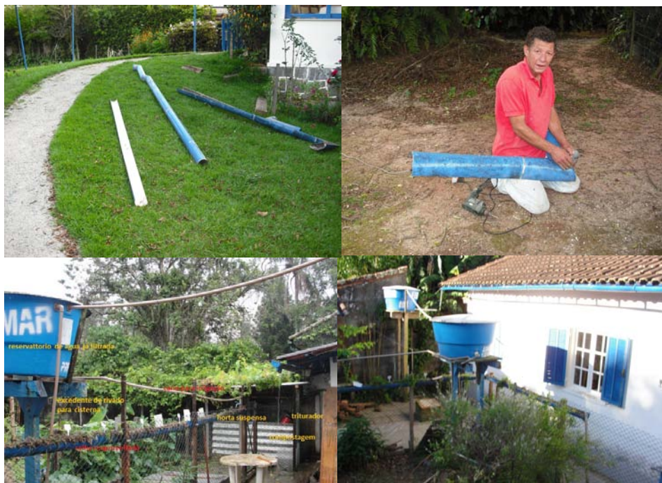
FIGURA 1. Coleta de água-calhas velhas se tornam horta suspensa. Coleta, filtragem e distribuição da água da chuva
