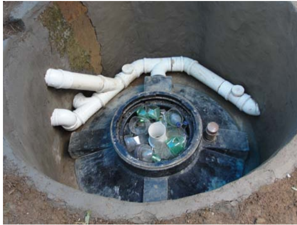
FIGURA 3 O produto do bidigestor é usado na compostagem com restos Vegetais.
